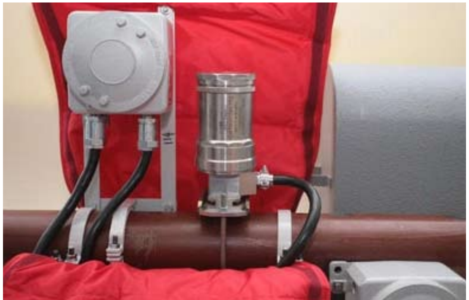
Компоновка ДСП-АКЭ-2 на газопроводе
